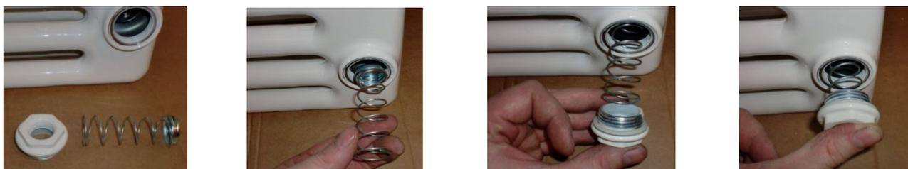
Una volta inserito il piattello ed avvitata la riduzione al mozzo, la molla viene schiacciata e mantiene il diaframma nella corretta posizione. Così l'installazione è completata.
